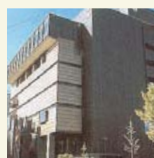
▲伝統ある京都西陣に建つ 西陣会館
